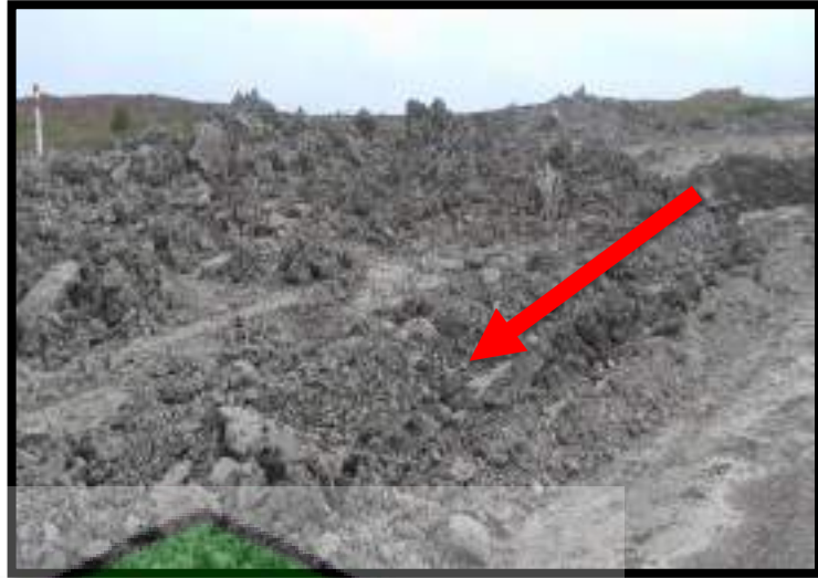
Gambar 4.21 Material Spoil Mengganggu Jalan
