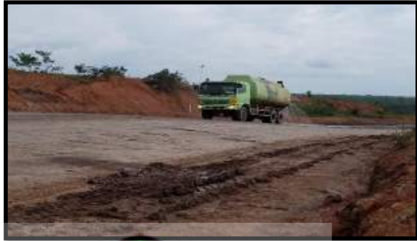
Gambar 4.42 Penyiraman Jalan
